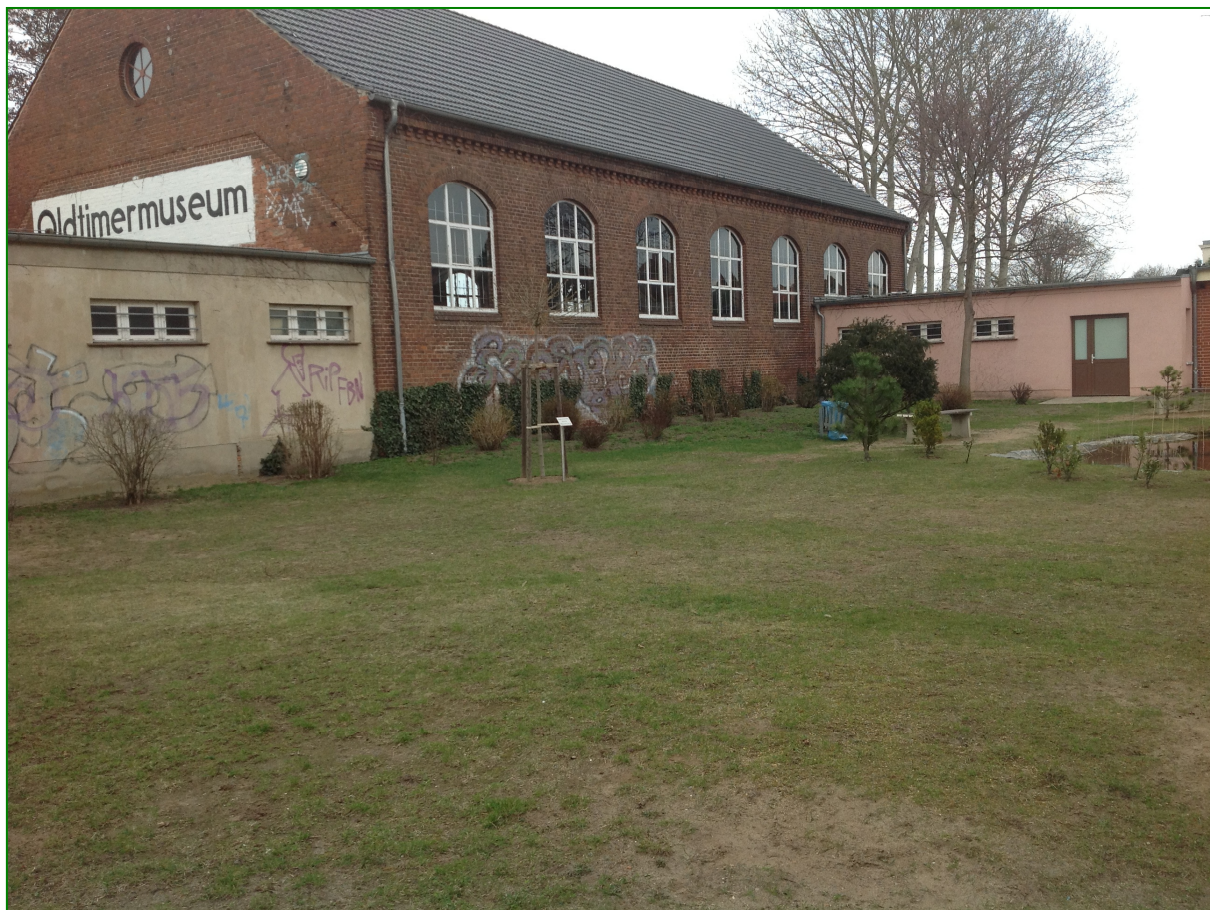
So sieht der Schulhof vom Haus 2 derzeit aus. Er soll umgestaltet werden. Foto: Hanno Taufenbach
